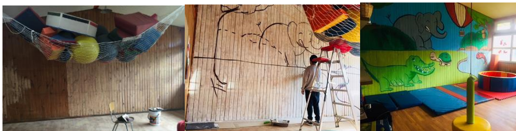
Foto 7: proceso de mejora de sala de rehabilitación
